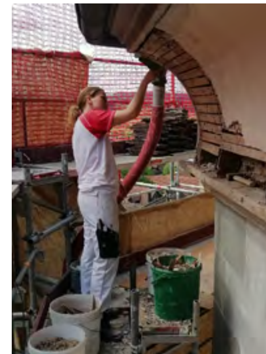
Die Stuckateurin flickt die Dachuntersicht
