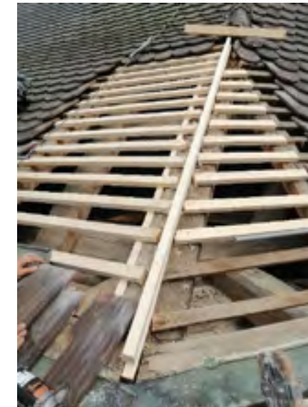
Durch eindringendes Wasser verfaulte die Dachunterkonstruktion
