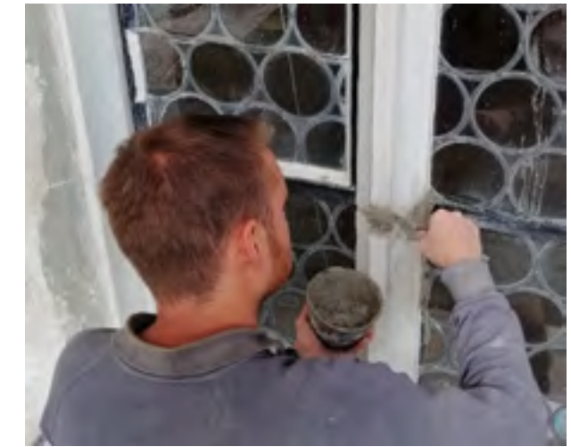
Reparaturarbeiten am Sandstein
