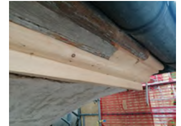
Sanierung durch den Zimmermann
