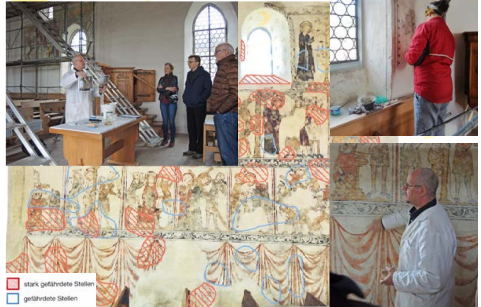
Bilder oben: Der Mörtel mit den aufgemalten Fresken löst sich vom darunterliegenden Mörtel. Restaurator Rolf Zurfluh erklärt, mit welchen Methoden die Schäden repariert werden. Eine Übersichtsaufnahme zeigt, wo und in welchem Umfang die Schäden vorliegen.
